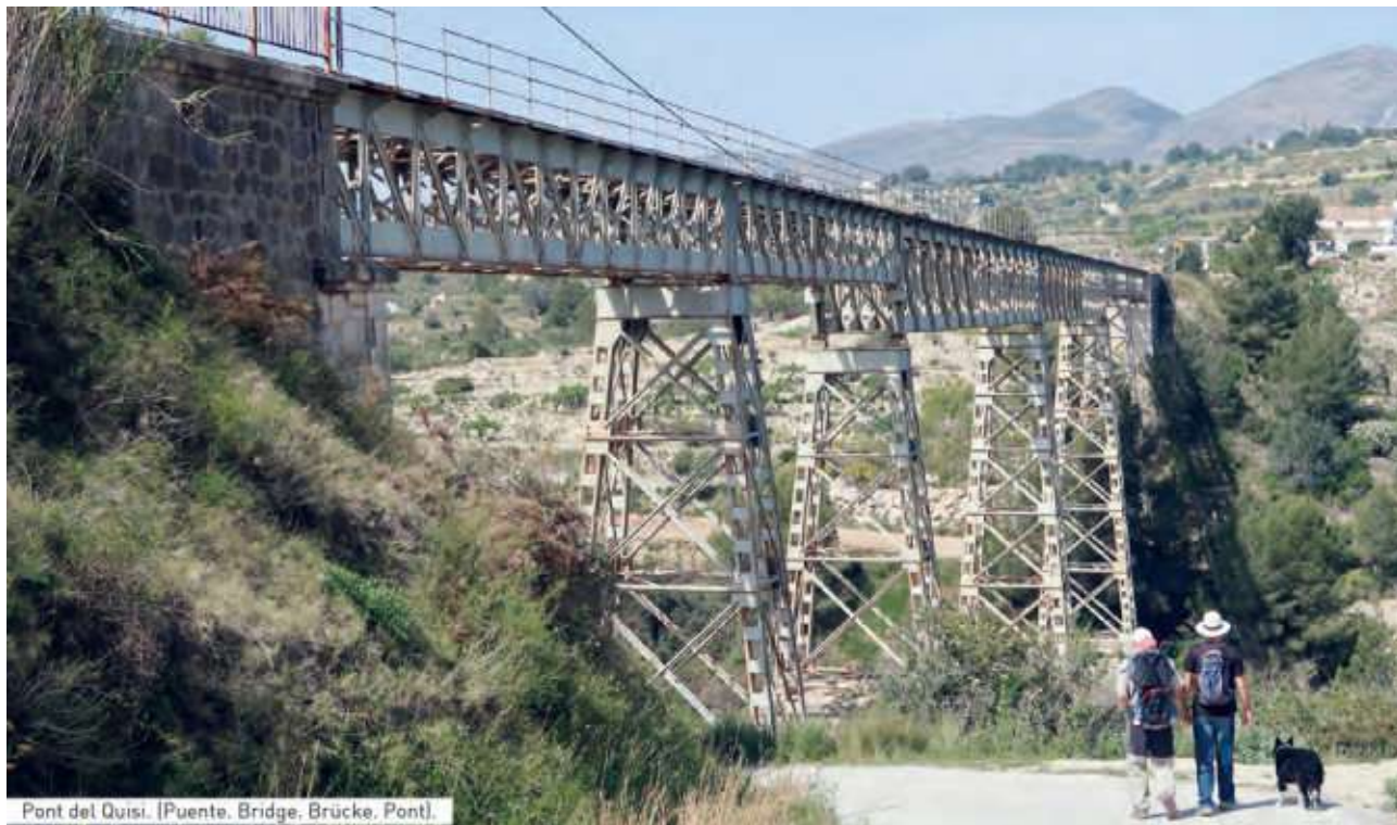
Pont del Quisi. (Puente, Bridge, Brücke, Pont).
